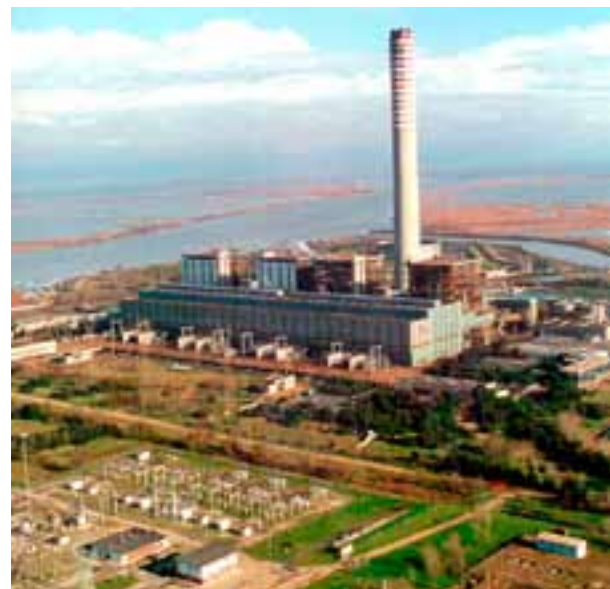
La centrale termoelettrica di Porto Tolle
