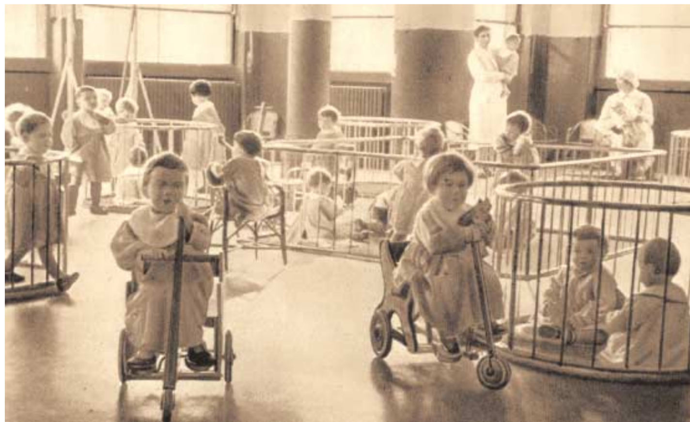
Città dell'armonia. Nella foto, del 1935, si vede la "Sala dei giarelli" del nuovo giardino d'infanzia di Valdagno. L'asilo era una delle tante istituzioni sociali che, insieme alle abitazioni per dirigenti, impiegati e operai, costituivano la "città dell'armonia". Costruita, su un terreno di 54 ettari, da Gaetano Marzotto senior tra il 1927 e il 1937. Tutte queste strutture, con la sola eccezione del teatro e delle piscine scoperte, sono ancora funzionanti.
